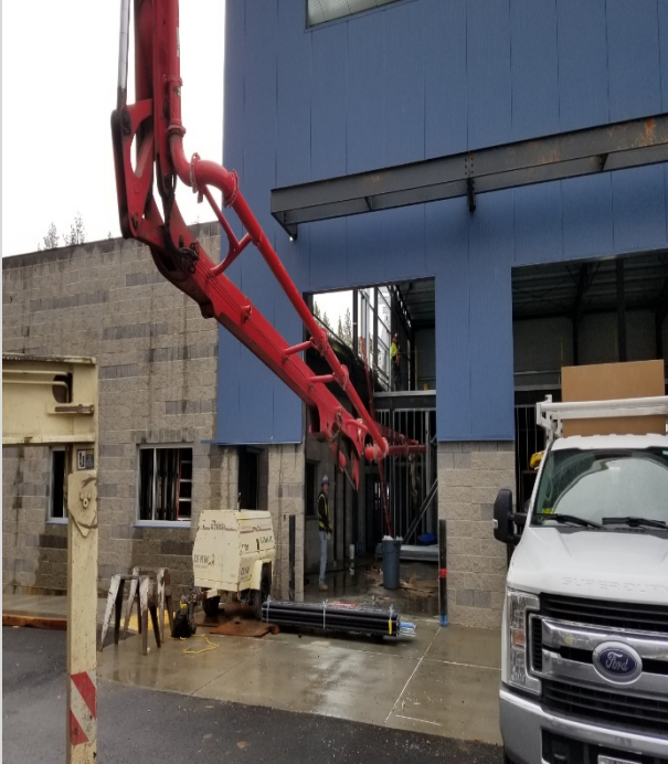
Photo 1 - Egpt Mezzanine Concrete Pour
